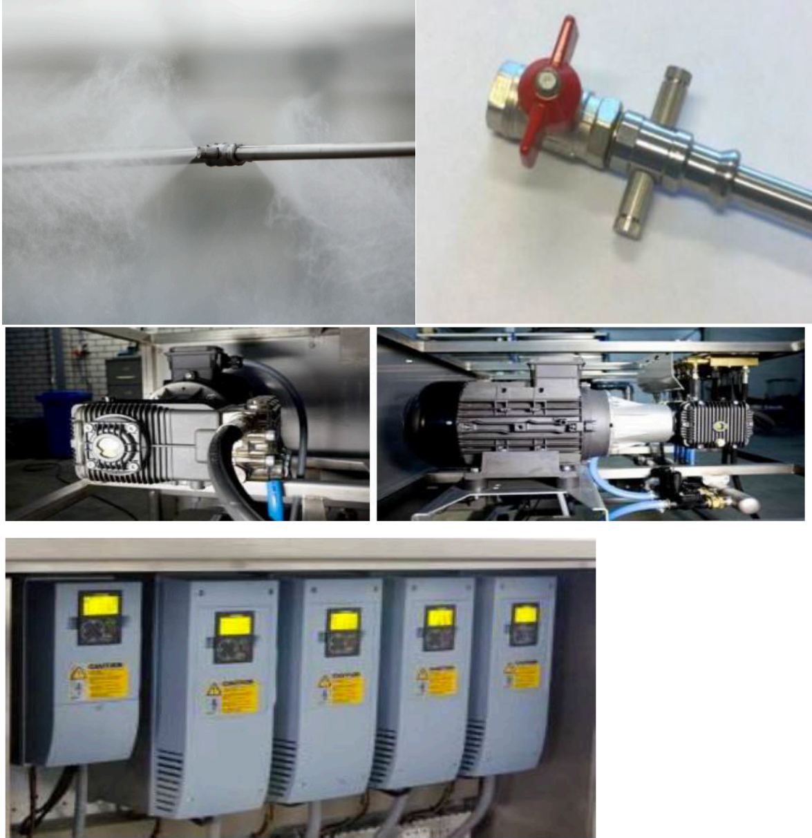
Sisleme motorları ve elektrik üniteleri
